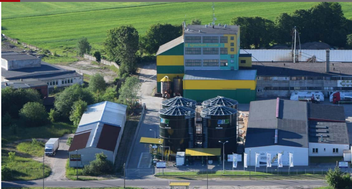
Agrochem Puławy Sp. z o.o. – baza w Człuchowie. Po lewej widoczne są zbiorniki nawozów ciekłych RSM.
