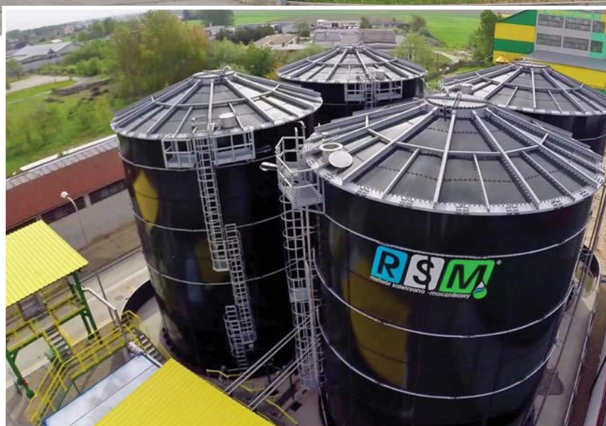
Zbiorniki RSM i stacja załadownicza ciekłego nawozu
